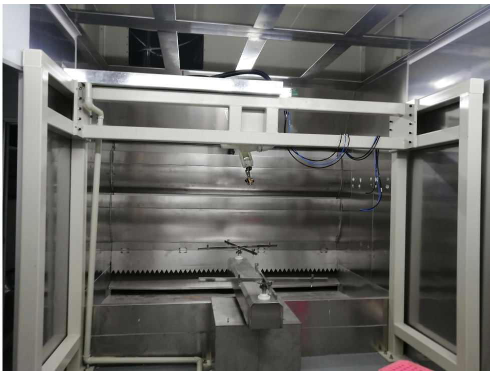
喷漆车间废气产生源
